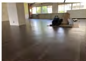
工事進捗状況
